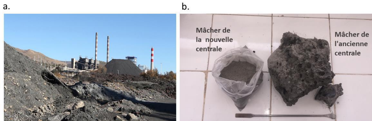
Fig. 4. Déchets de la centrale à charbon de Jerada (Lieu : Jerada, Maroc)
